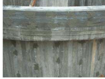
Tij deliklerinin doldurulmasında KÖSTER Repamor kullanılır
