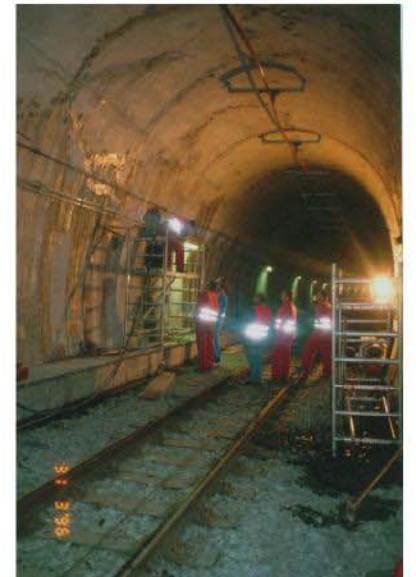
Tünel içinde beton çatlaklarına KÖSTER KB Pox IN enjeksiyon işleminin uygulanması
