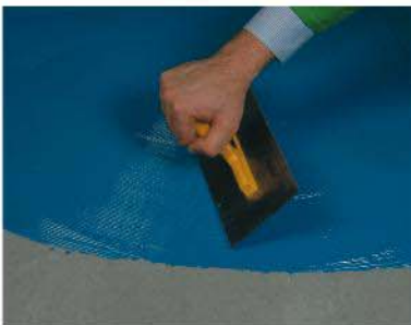
KÖSTER KB Pox LF-VS Struktur tarak mala ile ince ve homojen bir katman halinde zemine uygulanır
