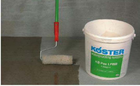
Zemin hazırlığı tamamlanmış olan yüzeylere KÖSTER KB Pox LF-BM astar olarak uygulanır.
