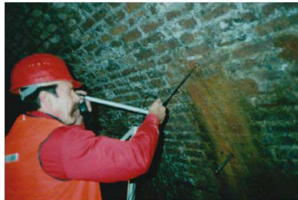
Dolu tuğladan imal edilmiş duvarlara enjeksiyon uygulaması
