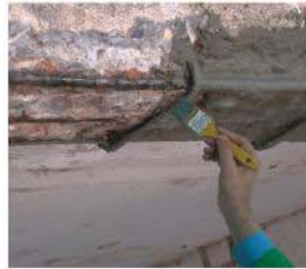
Temizlenen demir donatı üzerine KÖSTER Adex sürülerek koruma altına alınmalıdır
