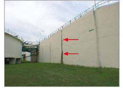
KÖSTER KB Pur GEL ile elastik şekilde yalıtılmış dilatasyon derzlerinin görüntüsü
