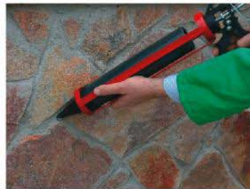
Doğal ve yapay taş derzlerinin su geçirimsiz ve dekoratif şekilde doldurulmasında KÖSTER BFH Geniş Derz kullanılır
