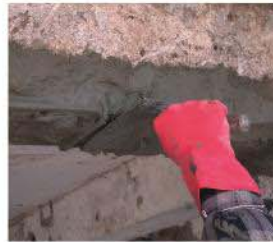
Yapısal tamir harcı KÖSTER Repamor ile tamirat işlemleri tamamlanmalıdır
