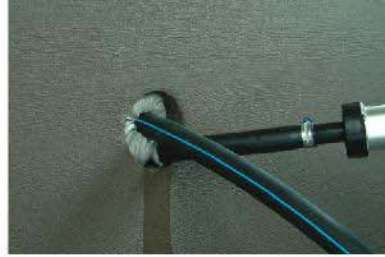
Kablo veya boru geçişi KÖSTER KB Flex 200 kalıcı elastik macun ile doldurulur
