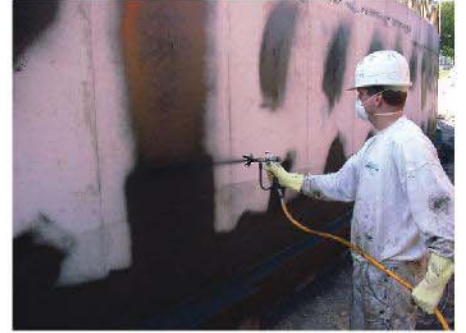
KÖSTER Deuxan 2K sürülerek veya püskürtülerek uygulanabilir
