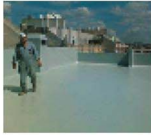
Gezilebilir teras yalıtımında KÖSTER KB Pur 214 uygulaması
