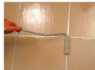
Daha sonra tüm yüzey rulo yardımı ile kaplanır.
