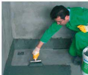
Islak hacim ve teras yalıtımında KÖSTER NB Elastik 2K uygulaması
