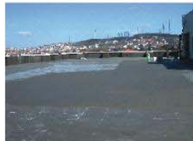
Islak hacim ve teras yalıtımında KÖSTER NB Elastik 2K uygulaması
