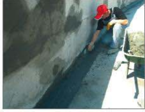
Köşe pahlarının oluşturulmasında KÖSTER Repamor kullanılır
