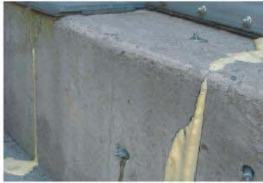
Nemli çatlaklara yapılan uygulamalarda KÖSTER KB Pur IN 2 su ile reaksiyona girerek çatlakların yalıtımını sağlar
