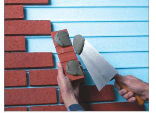
Kaplama tuğlaların yapıştırılmasında KÖSTER BSK kullanılır
