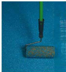
Yüzeyler kristal rulo ile taranarak portakal kabuğu dokusu elde edilir
