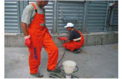
KÖSTER KB Pur IN 2 enjeksiyon reçinesi tek bileşenli ve yüksek basınçlı enjeksiyon pompaları ile uygulanır.
