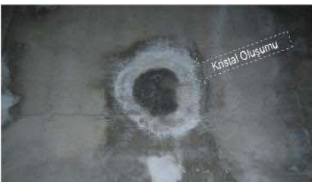
Yüzme havuzu yalıtımında KÖSTER NB Sistem uygulaması
