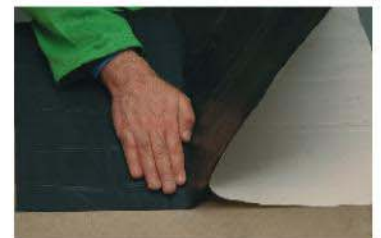
KÖSTER AW 15 astarlanmış yüzeylere kuvvetlice bastırılarak yapıştırılır
