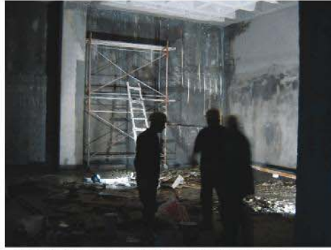
KÖSTER KB Pur IN 7 enjeksiyon reçinesi ile binanın bodrum katında soğuk derzlere yapılan enjeksiyon uygulaması
