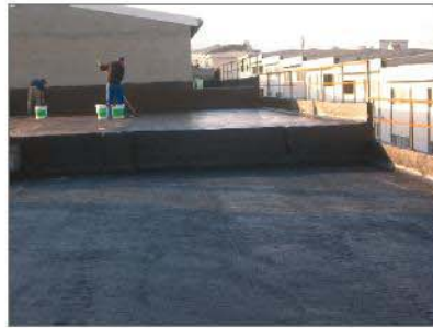
Teras yalıtımında KÖSTER Deuxan 2K uygulaması
