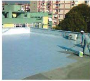
Gezilebilir teras yalıtımında KÖSTER KB Pur 214 uygulaması
