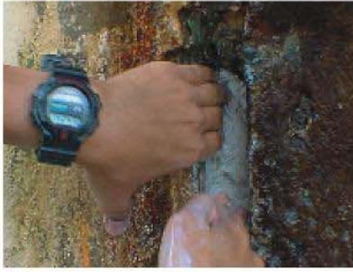
KÖSTER KB Pur GEL uygulama detayı
