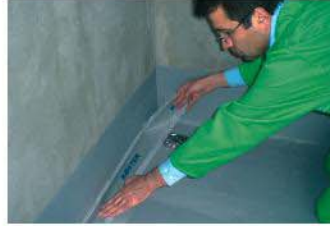
Köşe dönuşlerinde KÖSTER K120 pah bandı uygulanır
