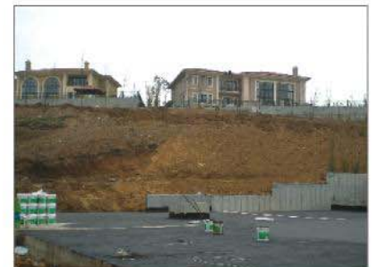
Yeraltı otopark üstü KÖSTER Deuxan 2K uygulaması
