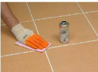
Parlak yüzeyler BK 1000 Primer ile astarlanır
