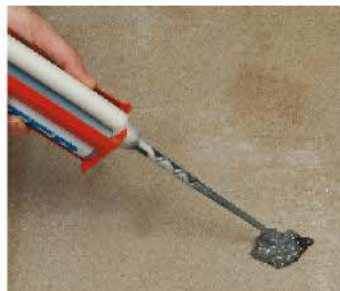
Kartuşların uç kısmındaki karıştırıcı bölge yardımı ile A ve B bileşenlere homojen şekilde karışır
