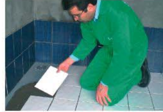
Çimento esaslı seramik yapıştırıcı ile seramikler yapıştırılır
