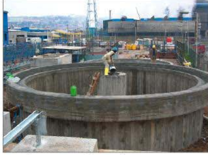
Atık su arıtma tesisinde KÖSTER NB Super ve KÖSTER Polysil TG 500 uygulaması
