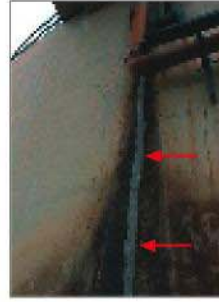
KÖSTER KB Pur GEL ile elastik şekilde yalıtılmış dilatasyon derzlerinin görüntüsü
