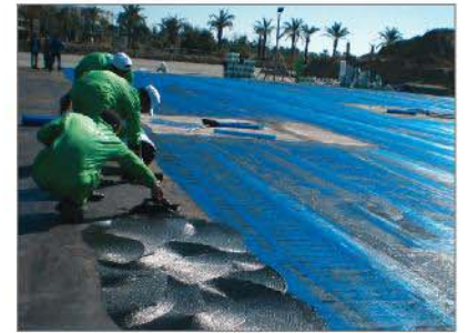
Temel bohçalama uygulamasında KÖSTER Deuxan 2K
