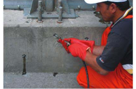
KÖSTER KB Pur IN 2 enjeksiyon reçinesi tek bileşenli ve yüksek basınçlı enjeksiyon pompaları ile uygulanır.
