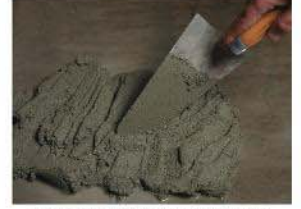
Eski beton yüzeyine KÖSTER AdePox uygulandıktan sonra bekledikten yeni beton uygulamasına geçilmelidir.
