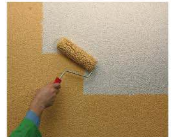
Mantolama sistemlerinde son kat dekoratif kaplama üzerine KÖSTER Dekor Boya uygulanır
