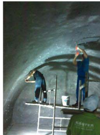
KÖSTER KB Pur 2 IN 1 enjeksiyon reçinesi ile yer altında kalıntı bir yapının çatlak enjeksiyon işlemi
