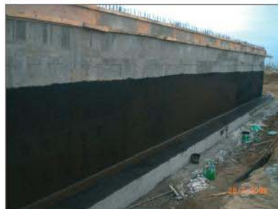
Perde duvar yalıtımında KÖSTER Deuxan 2K uygulaması
