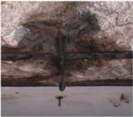
Korozyona uğramış olan demir donatı tam olarak temizlenmelidir
