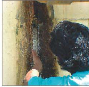
KÖSTER KB Pur GEL uygulaması sonucunda aktif suyun durdurulması
