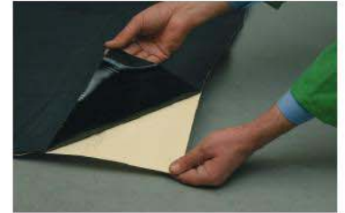
KÖSTER AW 15 alt kısmındaki silikon kağıt ayrılarak uygulamaya hazır hale getirilir
