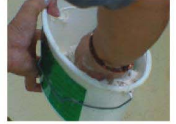
KÖSTER KB Pur GEL karıştırma işlemi
