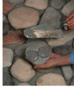
Doğal ve yapay taşların yapıştırılmasında KÖSTER BSK kullanılır
