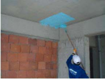
Tavanlarda alçı sıva uygulanmadan önce KÖSTER GipsoPLUS rulo ile uygulanır ve 24 saat kurumaya bırakılır
