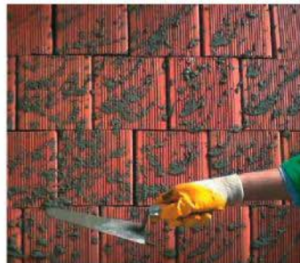
Serpme ve aderans harcı imalatında KÖSTER Latex kullanılır
