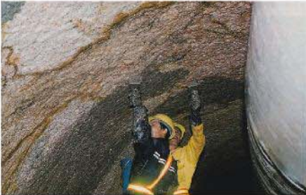
Bir tünelin içten yalıtımında KÖSTER NB Sistem uygulaması
