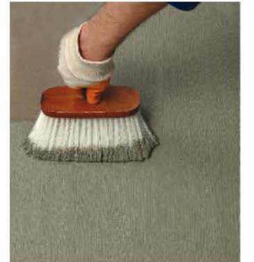
KÖSTER NB Elastik 2K sürülerek veya püskürtülerek uygulanabilir
