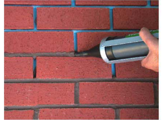
Dekoratif tuğla derzlerinin doldurulmasında KÖSTER BFH Geniş Derz kullanılır
