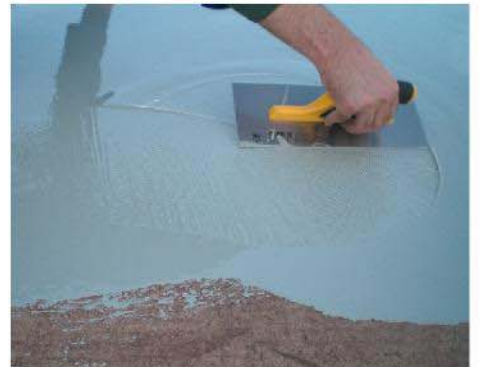
KÖSTER KB Pox LF-BM ile astarlanmış yüzeylere KÖSTER KB Pox LF-VL tarak mala ile yayılır ve kirpi rulo ile havası alınır.
