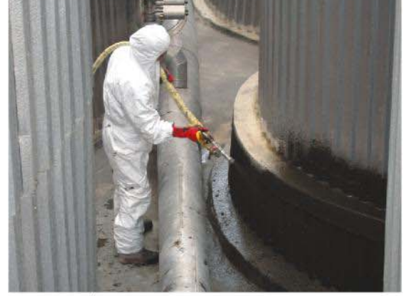
KÖSTER KBE Flüssigfolie fırça ile sürülerek veya püskürtücü ile püskürtülerek uygulanır
