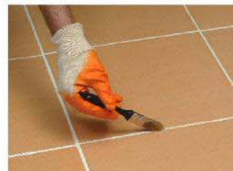
Öncelikle derzlere fırça yardımı ile uygulama yapılır.
