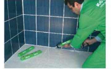
Zemin - duvar birleşim derzleri KÖSTER PU 907 poliüretan mastik ile doldurulur
